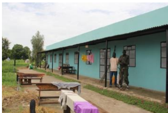
École à Bentiu, Sud Soudan, utilisée comme caserne par l'armée, 25 juillet 2014.
